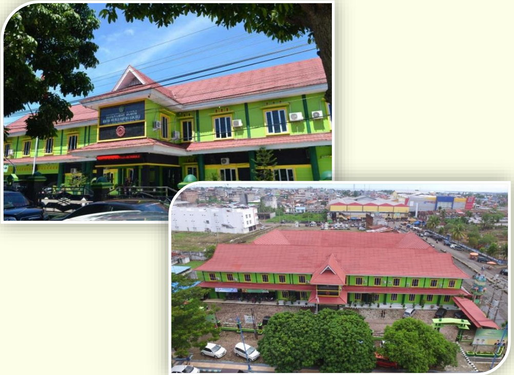
Gambar 2 Gedung Kanwil Kemenag Provinsi Bengkulu di Jl. Basuki Rahmat No.10 Kota Bengkulu
