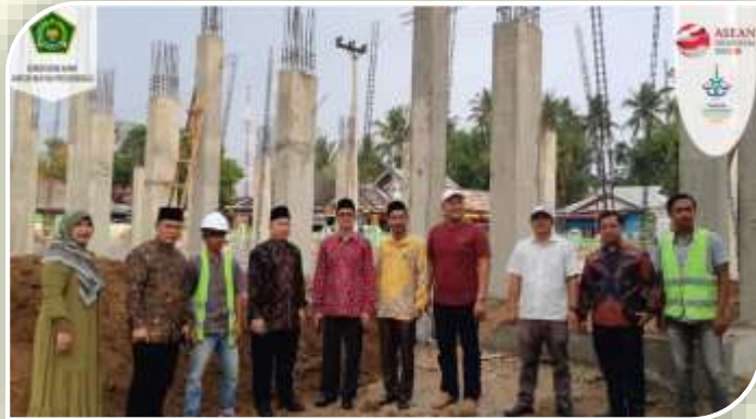
Gambar 3.2 Proses Pembangunan Gedung PLHUT Kabupaten Kaur
