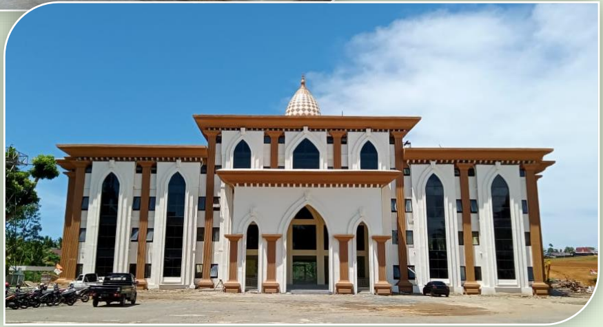
Gambar 3.1 Gedung Asrama haji yang dibangun tahun 2016 dan tahun 2021
